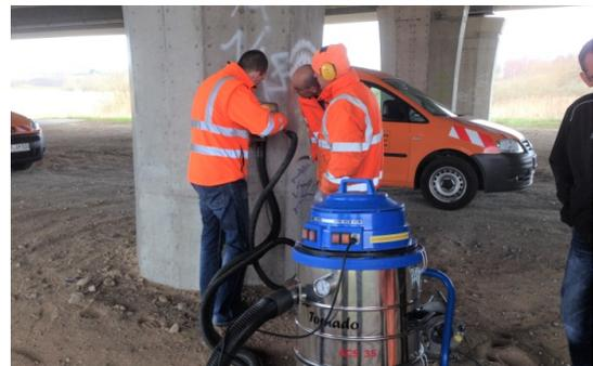
Die **Tornado ACS** Reinigungsmaschine ist die ideale Alternative zum Hochdruckreiniger. Ein weiterer großer Vorteil dieses Reinigungsgerätes ist der Einsatz im Winter. Da weder Wasser noch Chemie benutzt werden, kann der **Tornado ACS** auch bei Minustemperaturen ideal genutzt werden. Bequeme Handhabung, sichere Funktion sowie eine hohe Wirtschaftlichkeit sind die markanten Merkmale unserer Technik.
